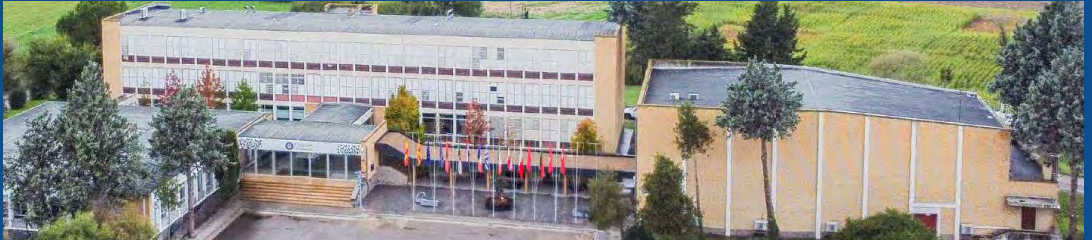
MAIN ENTRANCE AND PLAZA DEL MEDITERRÁNEO
